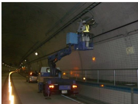
照明設備 点検作業中
