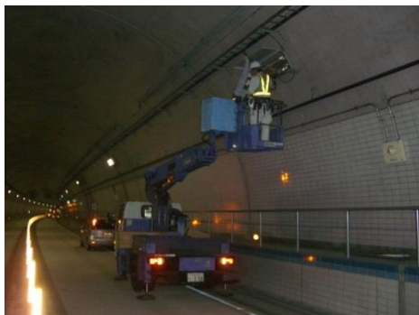
照明設備 点検作業中
