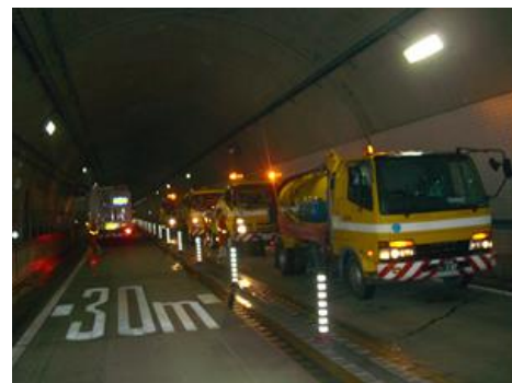
路面 清掃作業中
